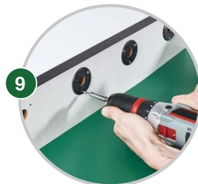
Innenrosetten von innen an den Tisch stecken und mit je 3 Torxschrauben befestigen.
